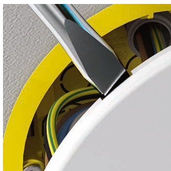
1 Usuwanie zatrzaskowej pokrywy puszki rozgałęźnej
